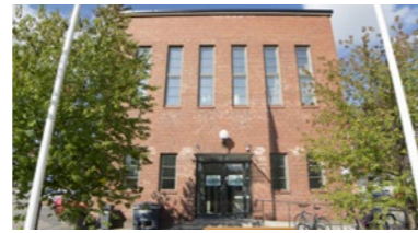
Tampereen Sähkölaitos, Tampere
