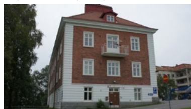
Koukkuniemen hallintorakennus, Tampere
